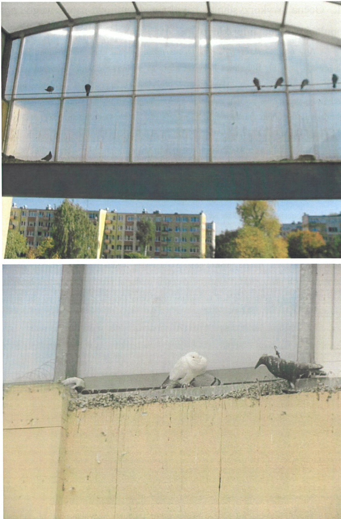
Fot. 3-4 Miejsca oraz struktury w obrębie budynku wykorzystywane przez gołębie miejskie
