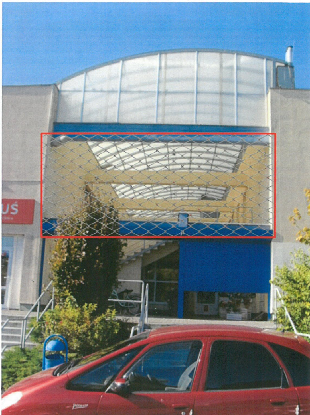
Fot. 6 Ograniczenie dostępu po obu stronach budynku do wnętrza łącznika poprzez zamknięcie przestrzeni (np. przy użyciu siatki) nad wejściami
