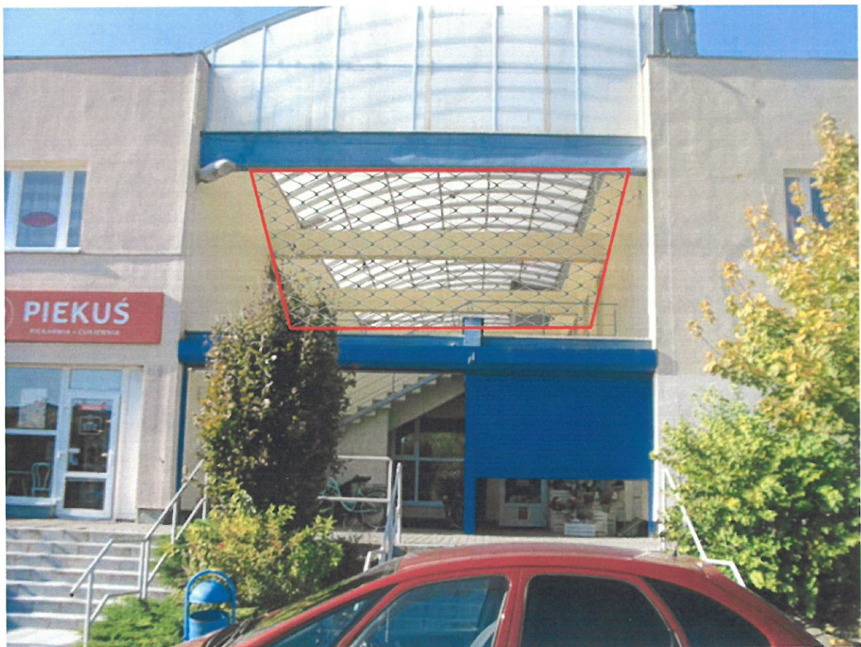
Fot. 8 Zamknięcie przestrzeni przysufitowej za pomocą siatki
