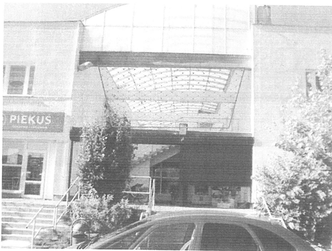
Fot. 8 Zamknięcie przestrzeni przysufitowej za pomocą siatki
