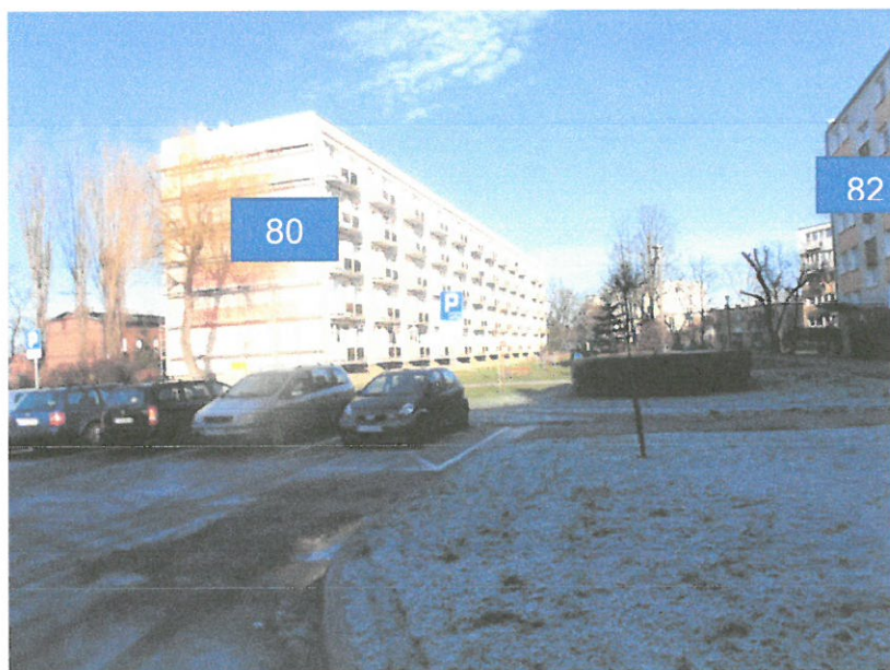
Zdjęcie nr 7. Widok na teren planowanej drogi pożarowej pomiędzy blokami nr 80 i 82.
