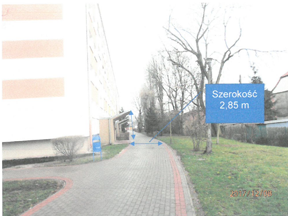
Zdj.nr 4 Widok na chodnik (drogę pożarową) od strony północnej obiektu.
