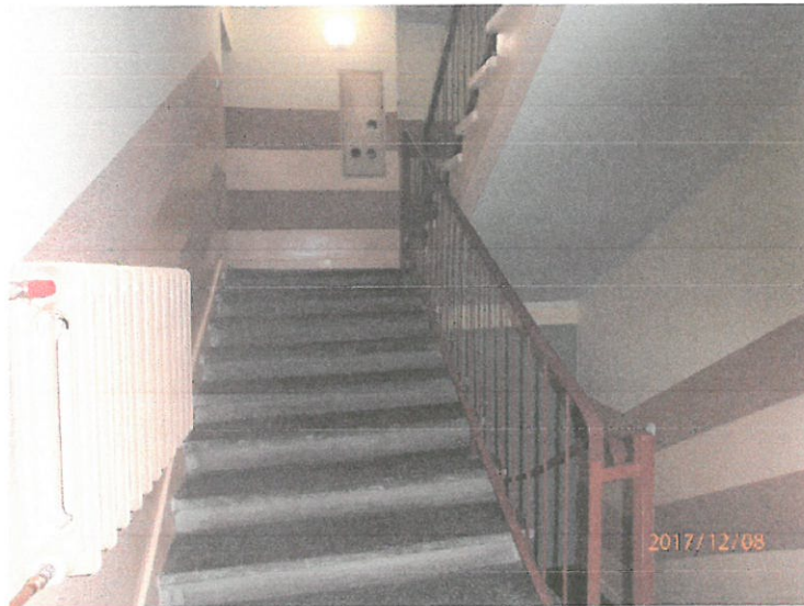
Zdjęcie nr 8 .Widok na klatkę schodową budynek nr 82.
