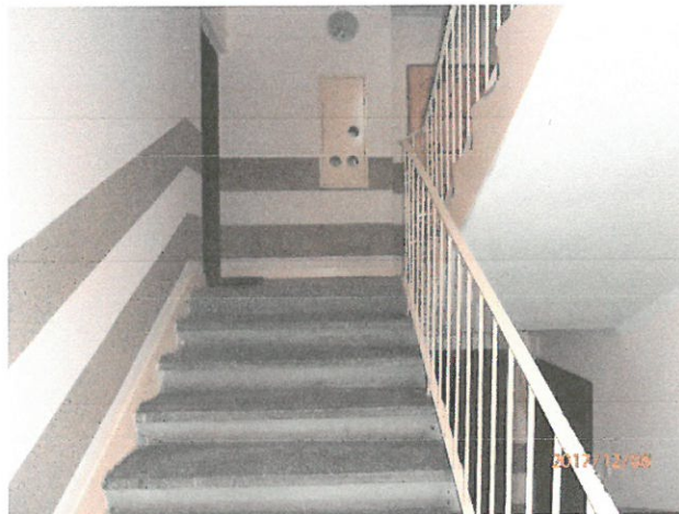
Zdj. nr 9.Widok na klatkę schodową budynek nr 80.
