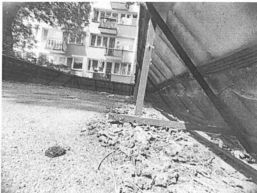
Fot. 7 Widok na stropodach i konstrukcję stalową zadaszzenia.
